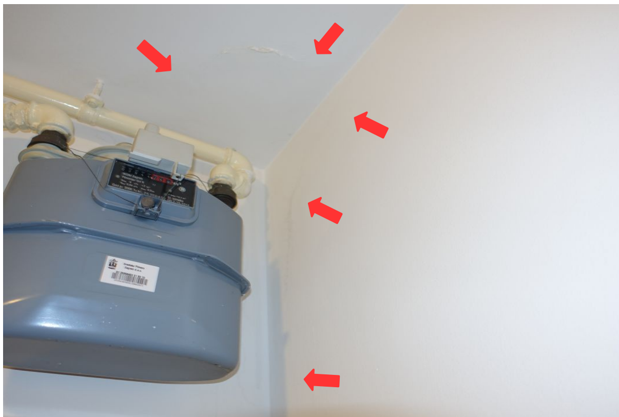
mrlja od curenja kod plinomjera
