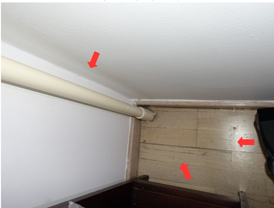
curenje niz kut zida i oštećenje na parketu
