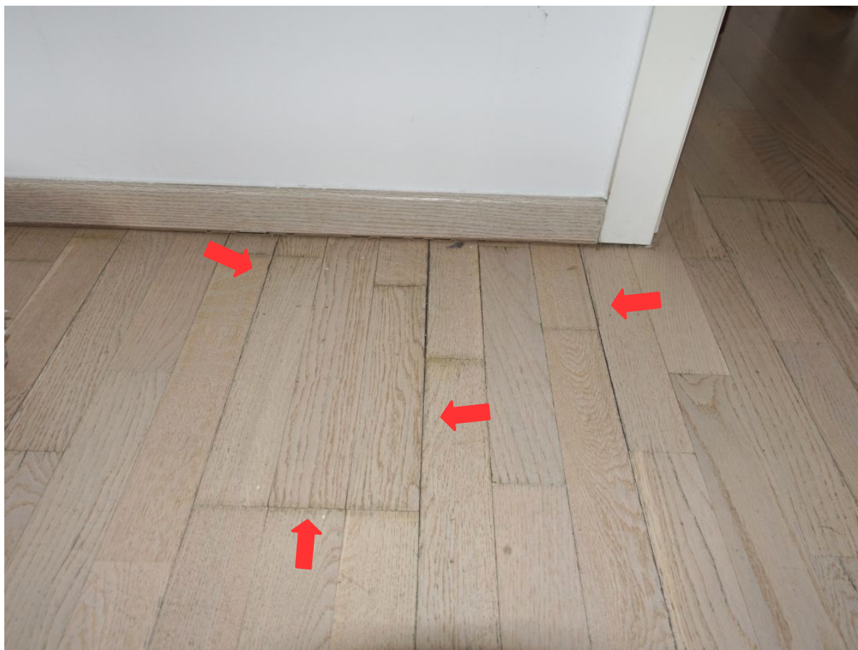
detalji oštećenja gotovog parketa - razdvajanje i vitoperenje letvica te tamna plijesan po rubovima
