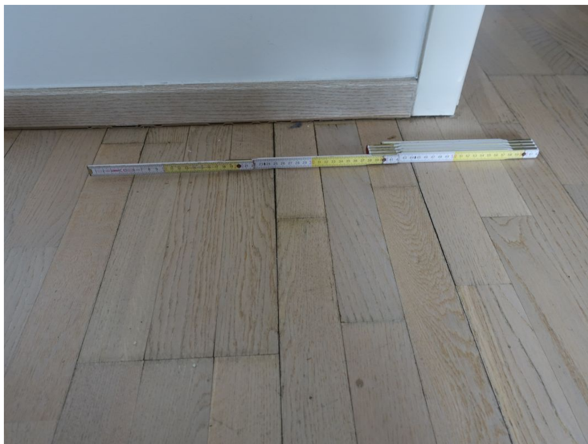
izmjera područja oštećenja gotovog parketa u sobi kod vrata
